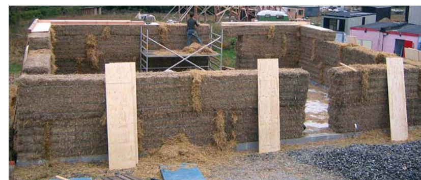
I den mest skrabe udgave rejstes det rå halmhus på 5-6 dage – vel at mærke når fundamentet er lavet i forvejen.
